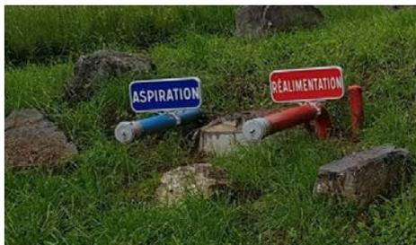
Cuve métallique enterrée, d'une capacité de 60 à 240 M<sup>3</sup>, alimentée aussi par le réseau AEP. Elles peuvent être connectées à un autre type de réserve ou poteau incendie pour assurer une plus grande contenance.
