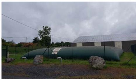
Les Réserves souples peuvent contenir de 60 à 240 M<sup>3</sup> d'eau. Il existe 2 modèles : un par remplissage direct au réseau d'Alimentation en Eau Potable (AEP), l'autre permettant aussi un raccordement à une autre réserve distante de moins de 800m.
